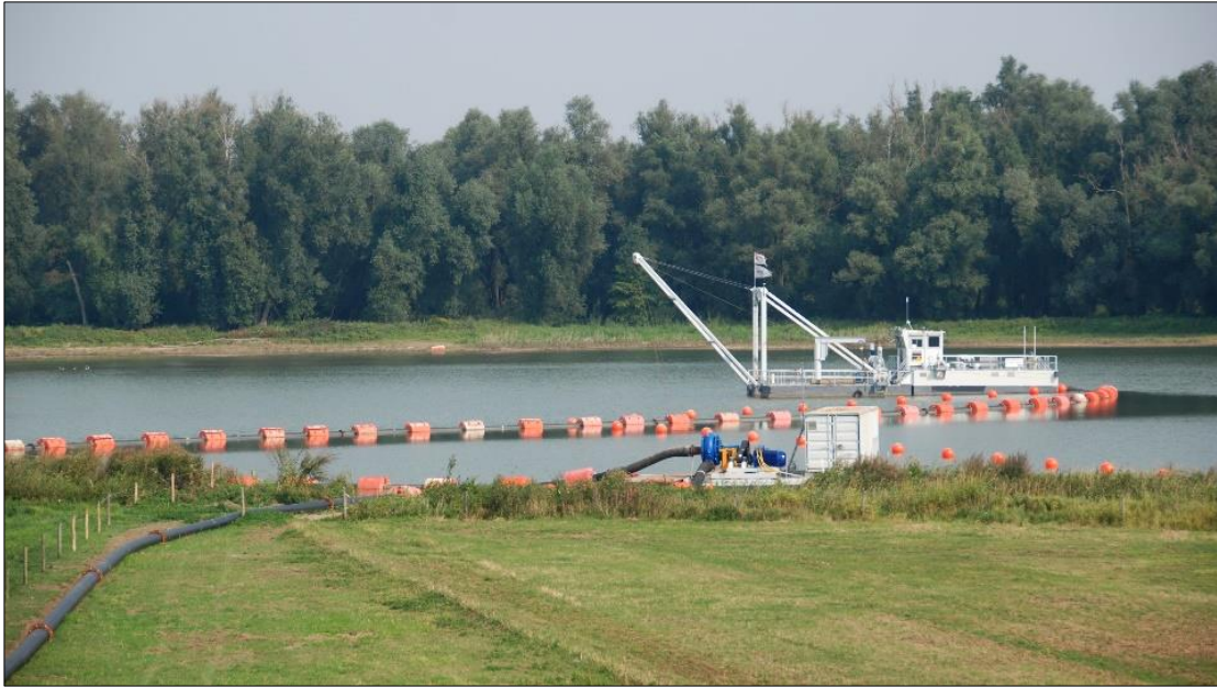
Figuur 7. Het winwerktuig “DOS 3” met persleidingen.
